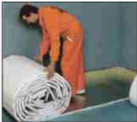
Rozkładanie izolacji
