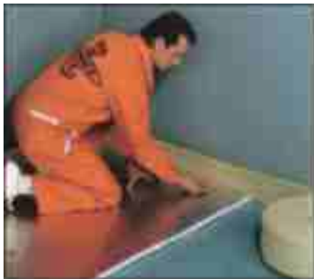
Mocowanie taśmy brzegowej
