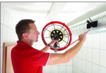
Rys. 6: Czyszczenie rur wentylacyjnych
