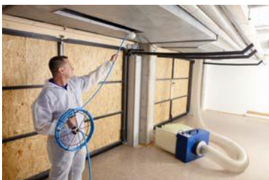
Rys. 16: Czyszczenie kanałów wentylacyjnych przy użyciu kuli prowadzącej i pejcza ciśnieniowego, odsysanie zanieczyszczeń za pomocą odciągu.
